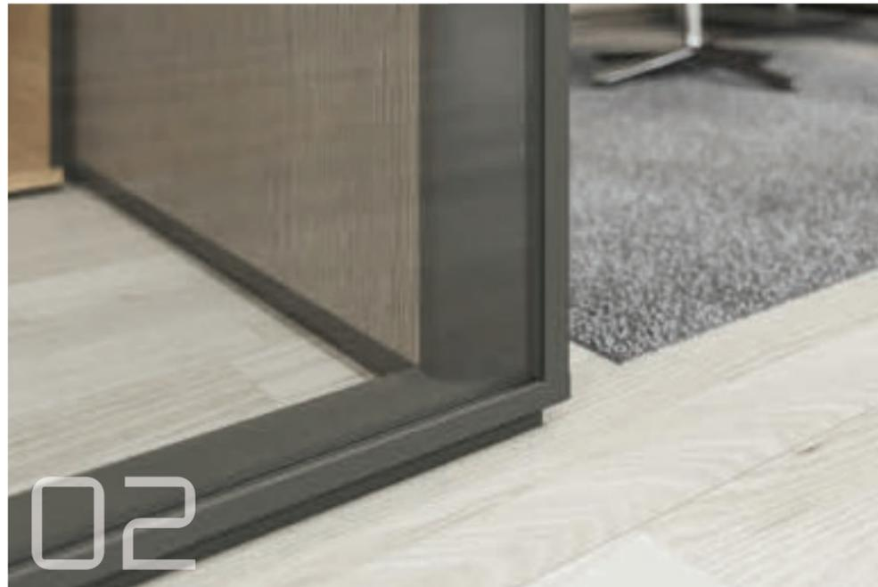
02 raccordement de panneaux vitrés à panneaux en placage
